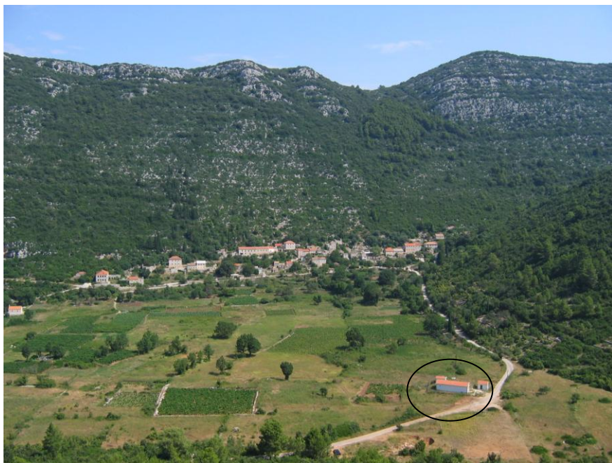
Slika 1. Blato na otoku Mljetu – postrojenje za preradu bočate vode.
